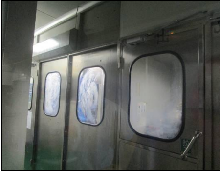
项目喷漆/喷油线
